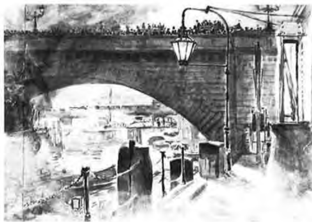
4 ロンドン橋の隅
